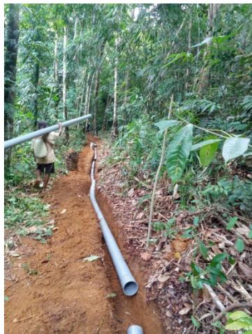
**Gambar 3** Pemasangan Pipa Transmisi Sumber Daya Air
